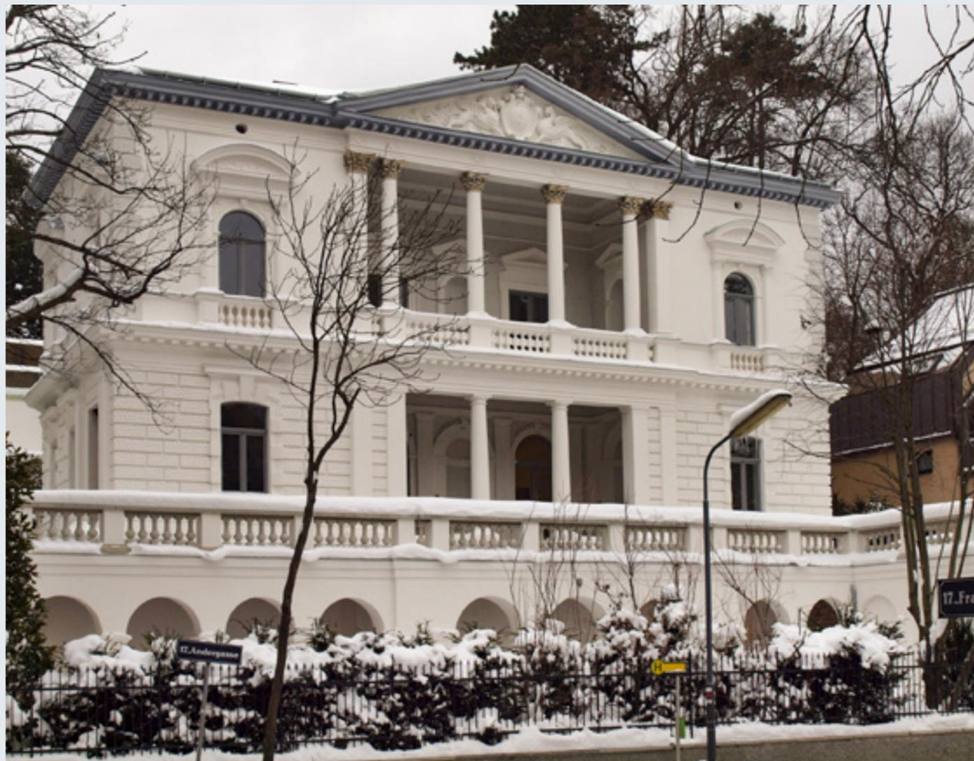
Ältere Fassadenputze, die im Laufe der Jahre unansehnlich oder dem heutigen Geschmack der Fassadengestaltung nicht mehr entsprechen, müssen nicht unbedingt entfernt und vollständig ersetzt werden. Ist die Putzschicht tragfähig und ist ihre Haftung zum Untergrund nicht geschädigt, kann sie erhalten, und ihr Aussehen und ihre Funktionalität durch eine dünnsschichtige Überarbeitung wieder hergestellt werden.
